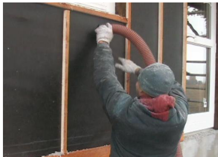
Gatavas sienas siltināšana
