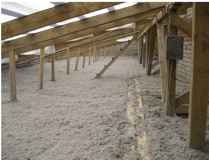
Bēniņu siltināšana
